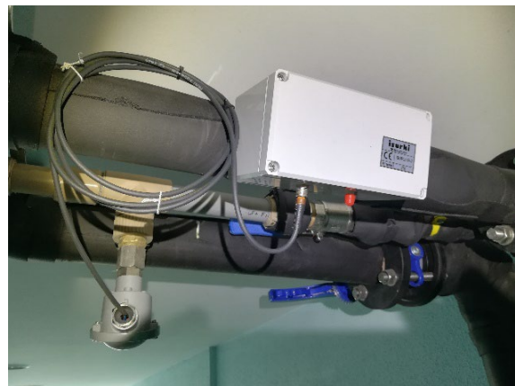
↑ Prevención de Legionela en red ACS mediante medición y registro de temperatura. ⇐ Ejecución especial en armario IP66, 300x265x165mm, con bornero, y panel solar opcional.
