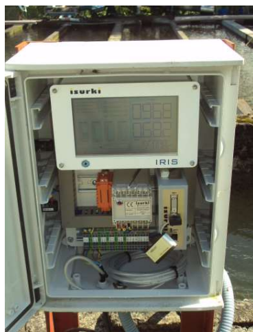
Ejecución en armario estanco para montaje a la intemperie (IP66) listo para conectar y funcionar.
