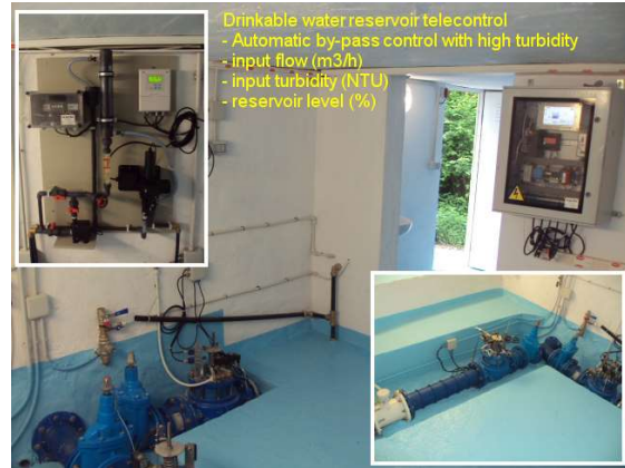
Telecontrol de un depósito de agua potable con regulación de caudal y control del by-pass.
