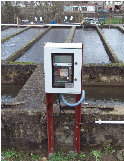
Aforo y registro de caudal en canal abierto a la entrada de una piscifactoría.
