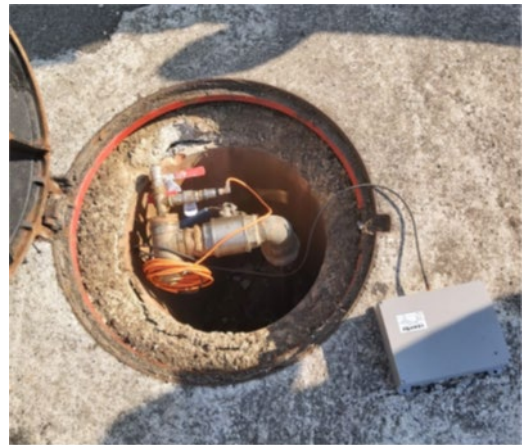
ISURLOG 2 registrando presión de servicio en una red de distribución de agua potable
