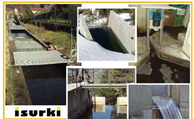
Instalaciones en servicio con sensores ultrasónicos e hidrostáticos.
