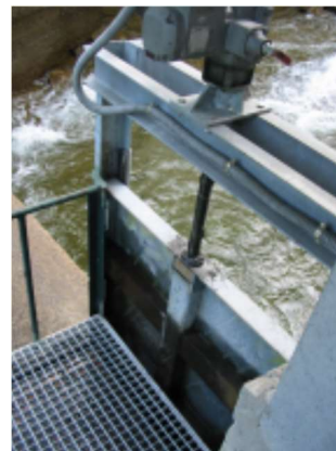
Control remoto inalámbrico de una compuerta de regulación de caudal través de WiFi o la nube (elemento limitador).
